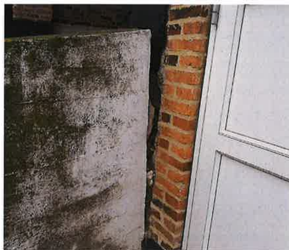
Støbt væg i indkørsel, adskilt fra facade i gård
